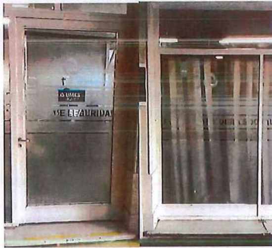
Puerta de ingreso existente
